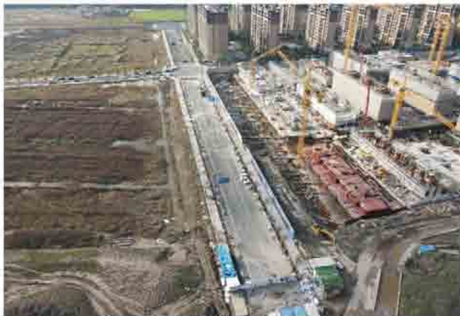
图 2-2 施工现场航拍图（2020 年 12 月）
