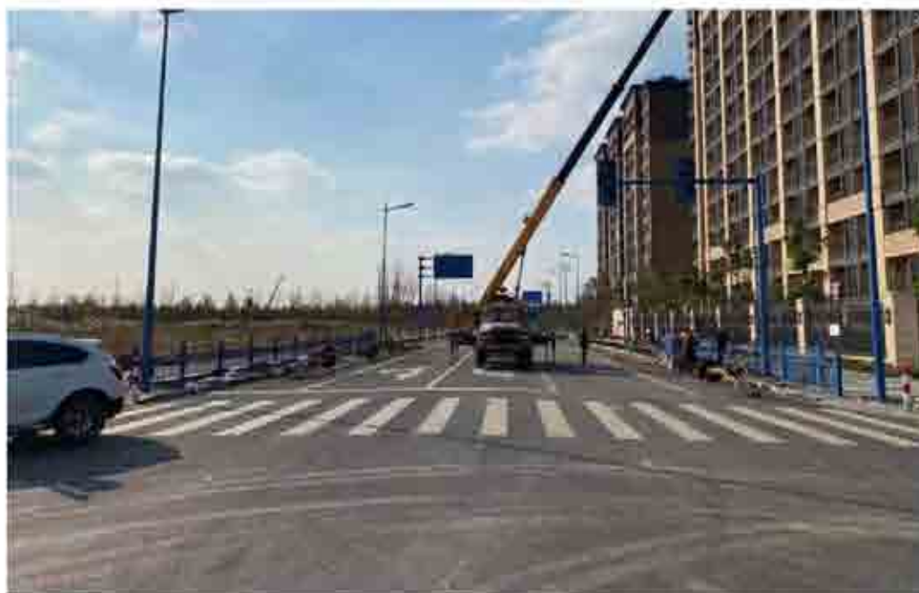
图 1-7 项目施工现场情况
